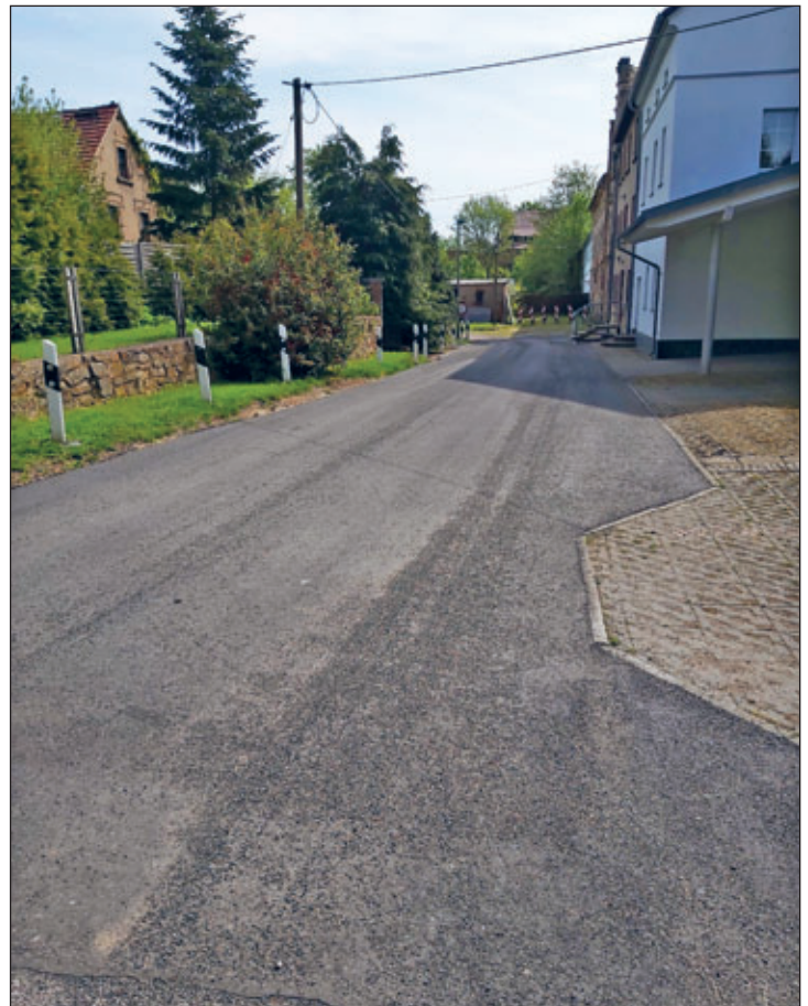
Fertigstellung Deckensanierung der Zufahrt Döschütz Nr. 8
