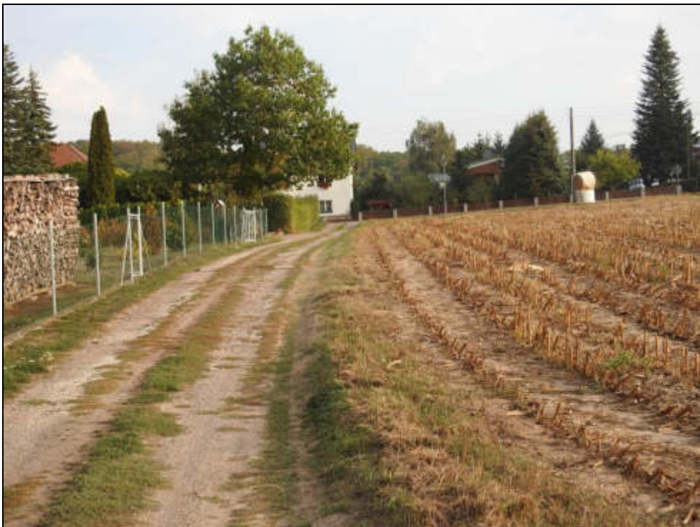
Bild 2: Wasserdurchlässig befestigter Weg entlang der westlichen Plangebietsgrenze (IB HAUFFE GbR, September 2018).
